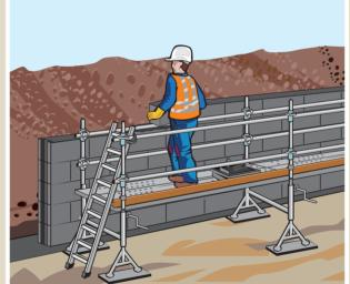
J'utilise un échafaudage sur tréteaux à manivelle pour exécuter le mur.
