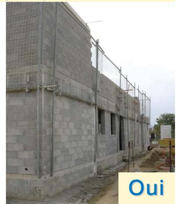
NB : La protection plaquée, répond aux exigences de robustesse et d'efficacité. Elle impose une réflexion en amont du chantier (calepinage), sur l'organisation des approvisionnements (appareil de levage) et sur l'installation de chantier (remblais, accès...).
