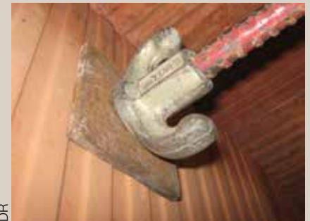
Fig. 6 - Support intermédiaire à cheville sur la dalle béton
