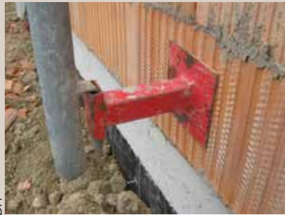
Fig. 5 - Support intermédiaire traversant la maçonnerie
