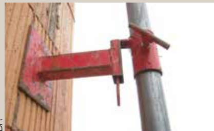
Fig. 5 - Support intermédiaire traversant la maçonnerie
