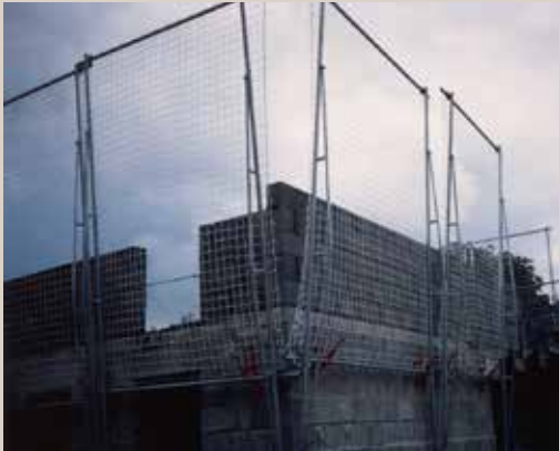
Fig. 13 Panneaux à filets
