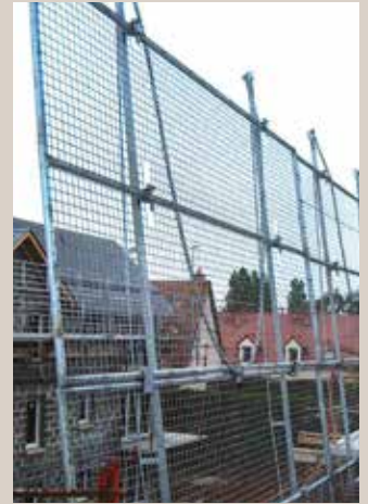
Fig. 14 Panneaux grillagés métalliques avec élingue retombante
