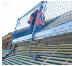
Fig. 4 Garde-corps intermédiaire de classe C.
